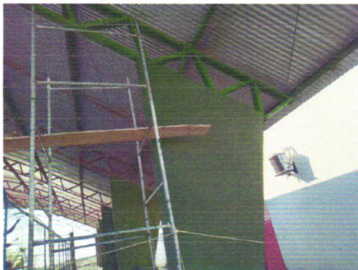
FOTO 01 – PINTURA DE ACABAMENTO COM APLICAÇÃO DE 02 DEMÃOS DE ESMALTE SINTÉTICO SOBRE SUPERFÍCIES METÁLICAS - R1
