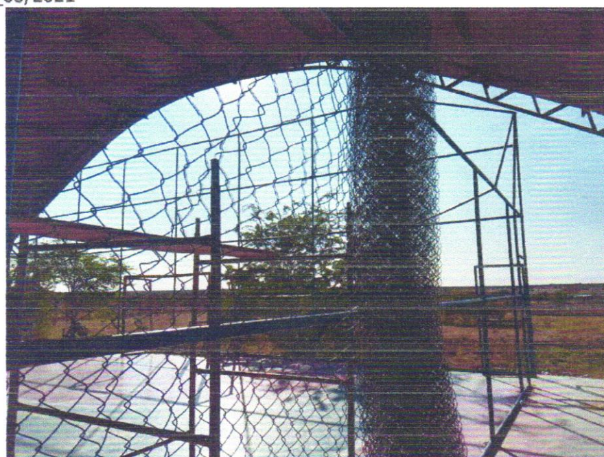
Foto 06 - ALAMBRADO PARA QUADRA POLIESPORTIVA, ESTRUTURADO POR TUBOS DE AÇO GALVANIZADO, (MONTANTES COM DIAMETRO 2", TRAVESSAS E ESCORAS COM DIÂMETRO 1 ¼ ), COM TELA DE ARAME GALVANIZADO, FIO 10 BWG E MALHA QUADRADA 5X5CM (EXCETO MURETA). AF_03/2021
