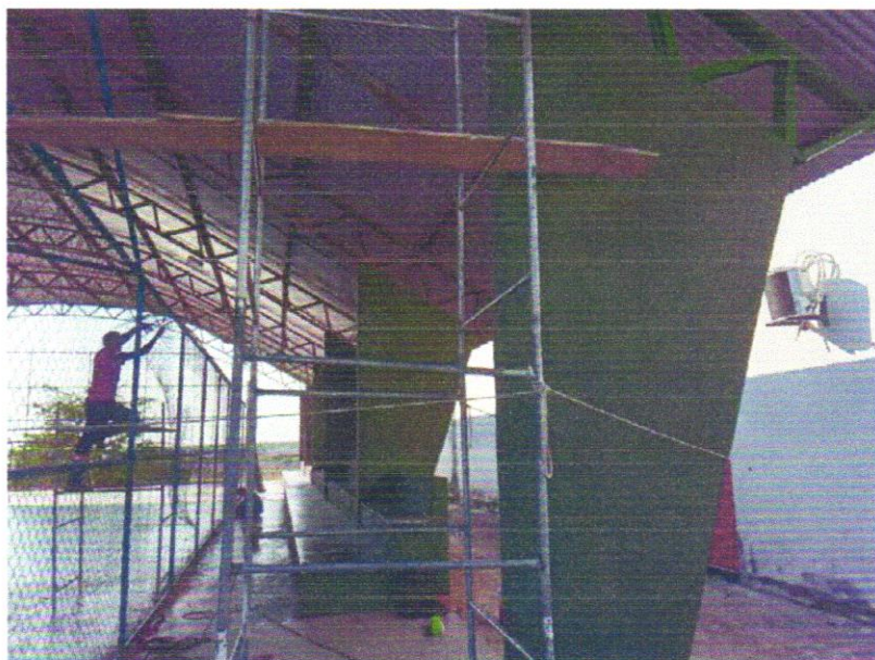
Foto 04 - ALAMBRADO PARA QUADRA POLIESPORTIVA, ESTRUTURADO POR TUBOS DE ACO GALVANIZADO, (MONTANTES COM DIAMETRO 2", TRAVESSAS E ESCORAS COM DIÂMETRO 1 ¼ ), COM TELA DE ARAME GALVANIZADO, FIO 10 BWG E MALHA QUADRADA 5X5CM (EXCETO MURETA). AF_03/2021
